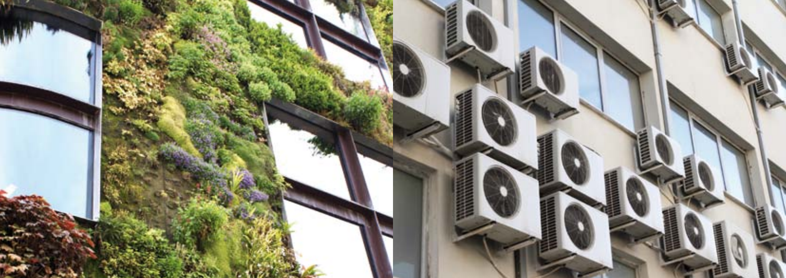
Begrünte Wand als Wärmedämmung
