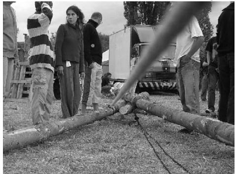
Ein Jahr abgelagerte Stämme sind leichter. Für die Stämme müssen am Aufbauort Löcher im Abstand der halben Stammlänge gegraben werden, deren Sohle im Idealfall noch mit Kies oder Schotter gefüllt wird (pro Meter Stammlänge bis Knoten 10cm tief). Damit die Stämme auch wirklich da reinrutschen, machen sich Ausrichtungsgräben ganz gut. Bei jahrelang stehenden Bauten sollten mindestens die in der Erde stehenden Enden geschält und angekokelt werden.
