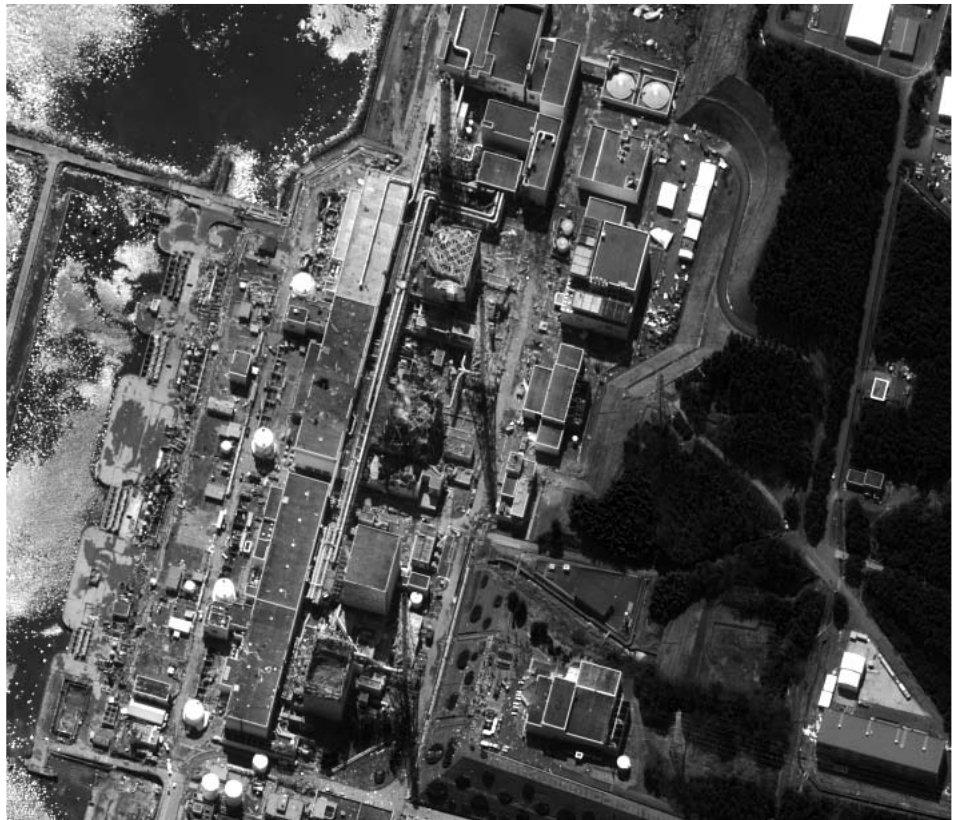
Das Kraftwerk Fukushima Dai-ichi am 17. März 2011
