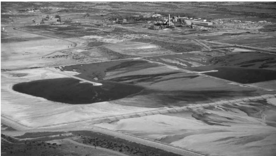
Tailing Ponds mit gelbem Atom-müll bei der Olympic Dam Mine
