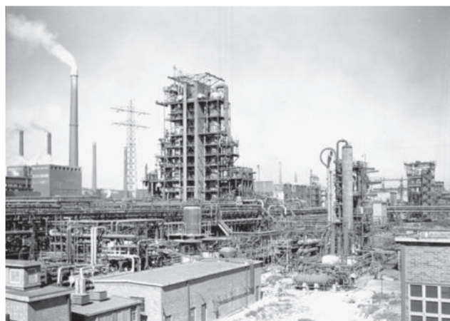
Leuna-Werk, Destillationsanlagen in der Treibstoffherzeugung, 1959
