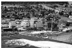
Auf dem Gelände des Sodawerkes Staßfurt, Freifläche im Vordergrund, wird die Müllverbrennungsanlage errichtet.
