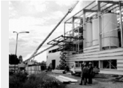
Noch haben die Bauleute das Sagen, damit in wenigen Monaten die neue Produktionsanlage in den Rohbau montiert werden kann, der anschließend komplettiert wird.
