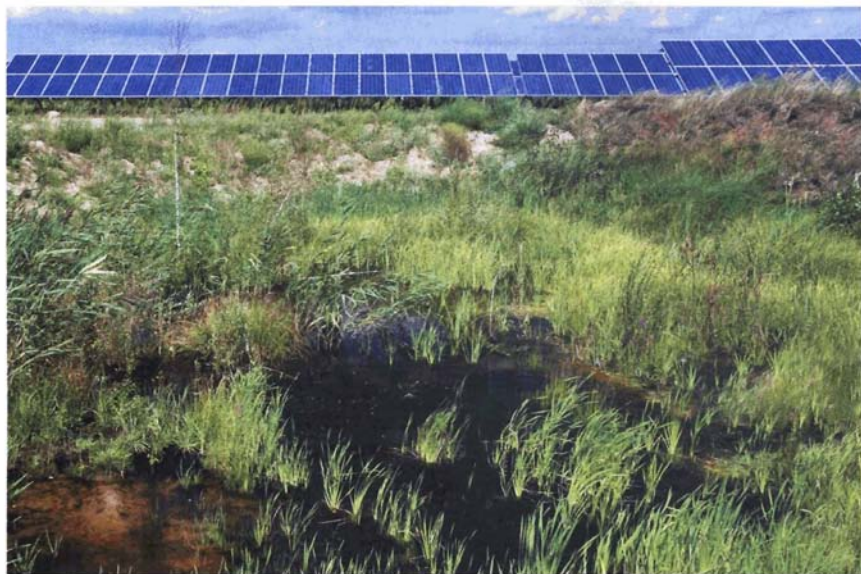
Tümpel des Anstoßes: Fünf von zwanzig Kleingewässern wurden bei den Bauarbeiten verschüttet und mussten anschließend renaturiert werden
