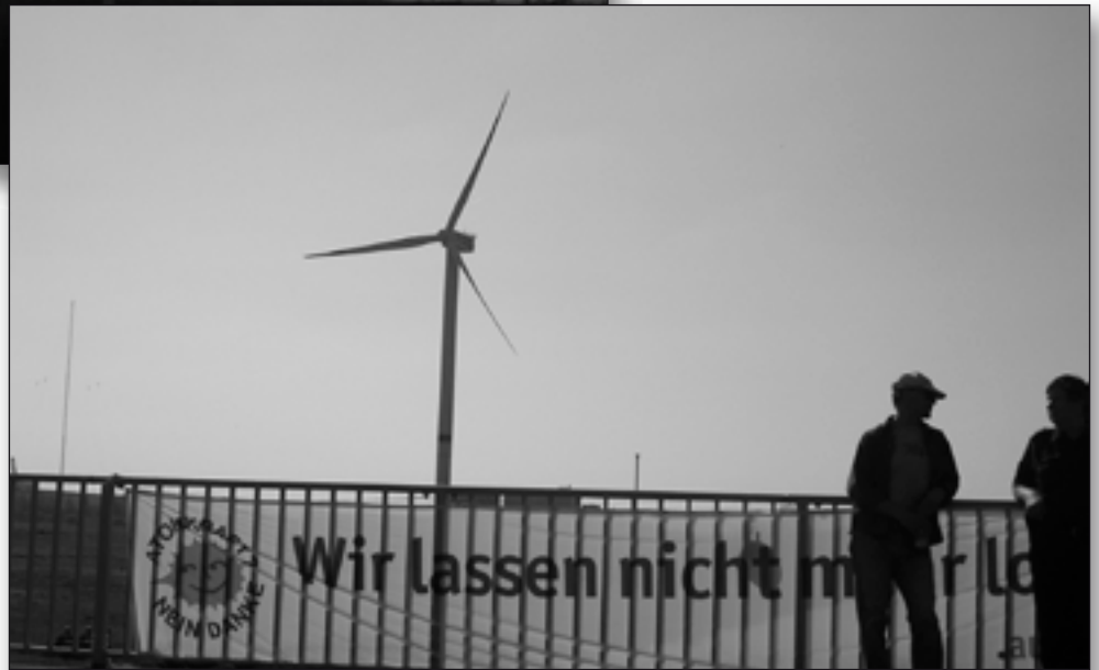
5-MW-Prototyp von Repower neben dem AKW-Brunsbüttel Fotos: Wolfgang Pomrehn
