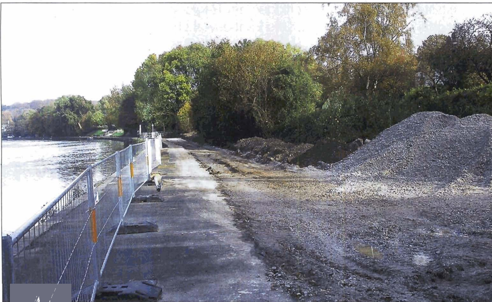
Abb. P 12: Baustelle für einen Radweg an einem Fließgewässer.
