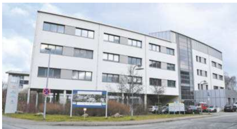
Der Technologiepark Warnemünde, in der Friedrich-Barnewitz-Straße, haben sich mehr als 30 Unternehmen angesiedelt.
