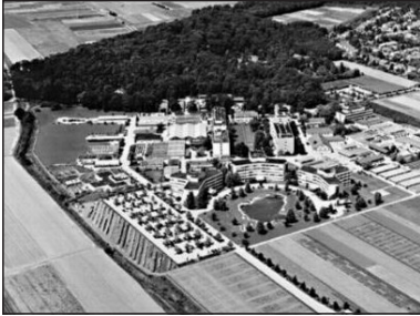
Foto: Gebäudekomplex auf dem BASF-Agrarzentrum südlich von Limburgerhof (Ortsrand rechts oben).
