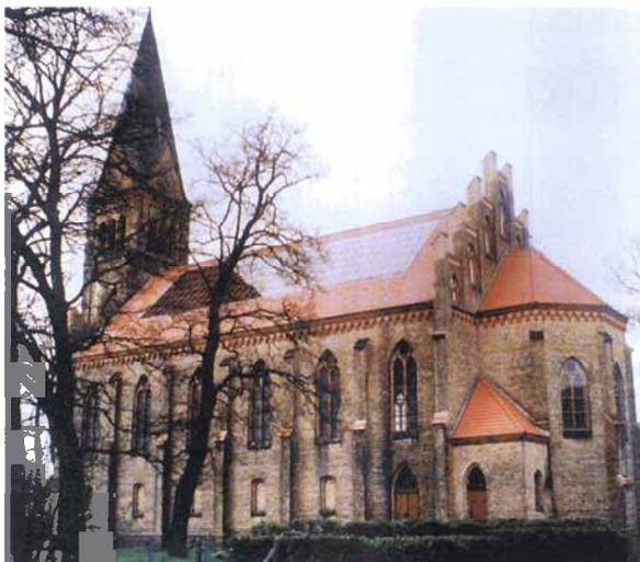
**Dachintegration von Solarmodulen aus amorphem Silizium, als Ersatz für herkömmliche Dachziegel in Friedersdorf bei Berlin.**
