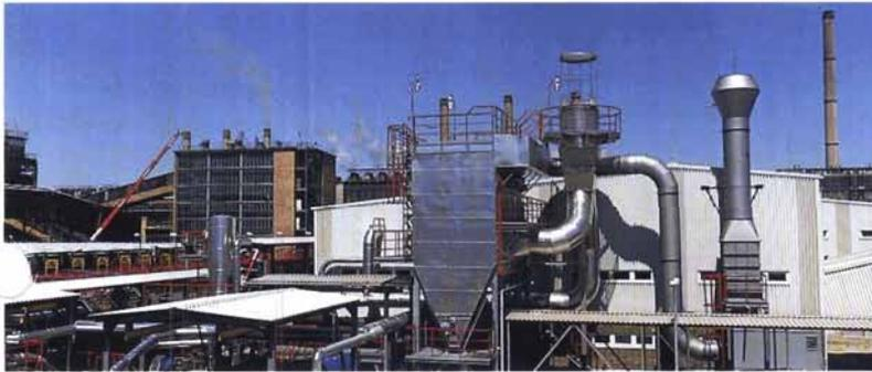
Entstaubungsanlage der Brikettfabrik Schwarze Pumpe im Lausitzer Revier
